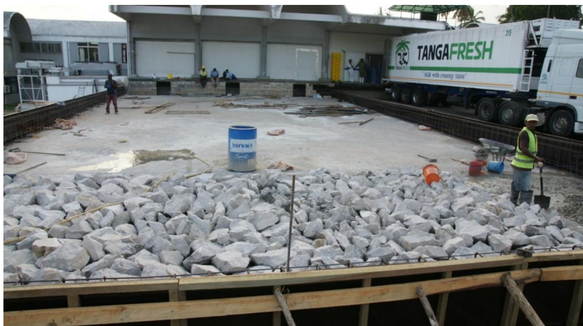
Ujenzi wa jengo jipya wa Kiwanda cha Tanga Fresh ukiendelea, Januari 2017
